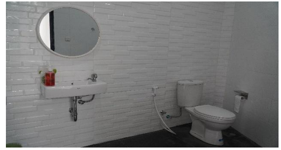
Sesudah Renovasi Prasarana Toilet
