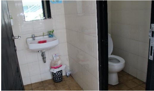
Sebelum Renovasi Prasarana Toilet
